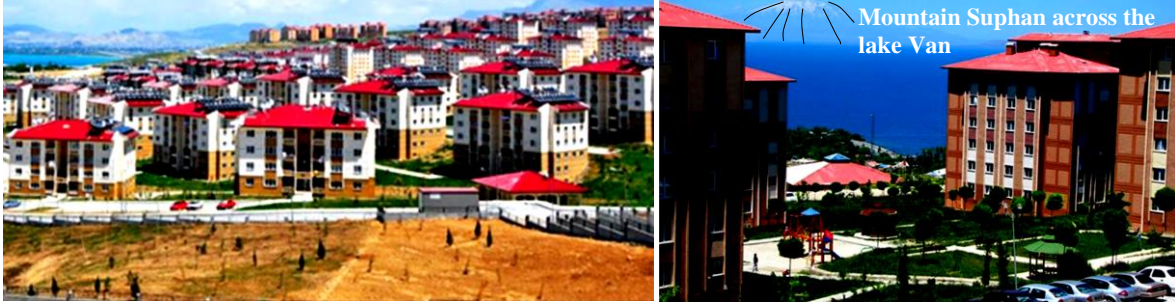
Şekil 20. 23.10.2011 ve 9.11.2011 tarihlerinde oluşan depremlerden merkez üssünün bitişiğindeki kayalık alanda kurulan ERDEMKENT hiçbir şekilde etkilenmemiştir (bkz. Şek. 19).
