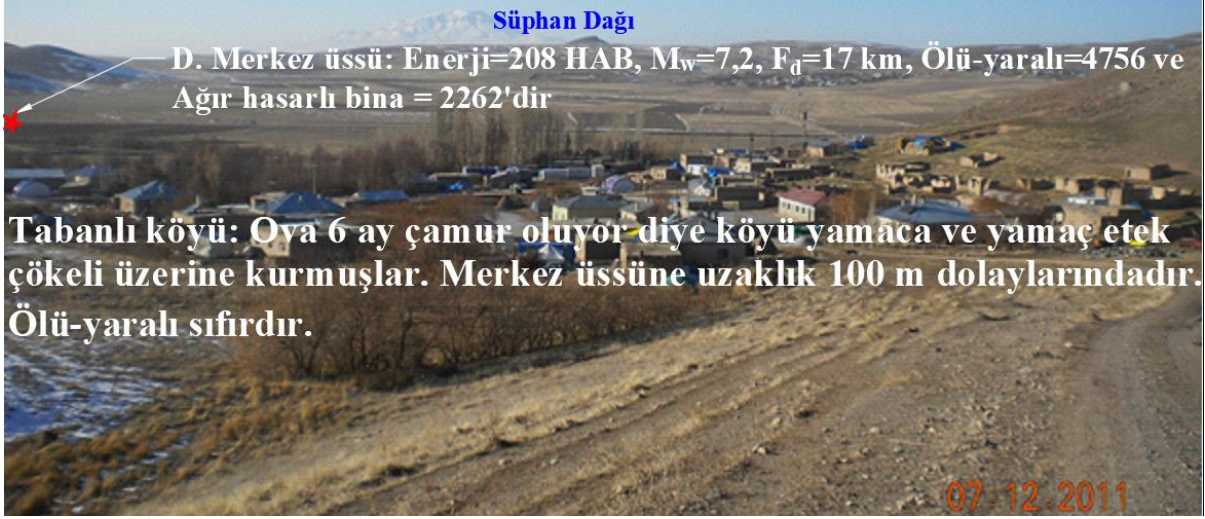
Şekil 18. Her şey o kadar açık ki, deprem merkez üssü bitişiğindeki kayalık zemine kurulan tabanlı köyüne dokunmazken 120 km uzakta Muş'un Bulanıksu ilçesinin Kocasu ovasındaki 15 köyün tamamını yıktı (bkz. Şek. 19).
